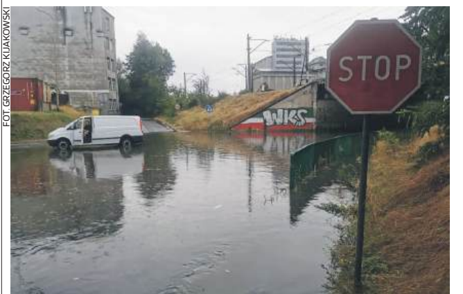
Po sierpniowej ulewie tunel na Ludwikowskiej był nieprzejezdny
