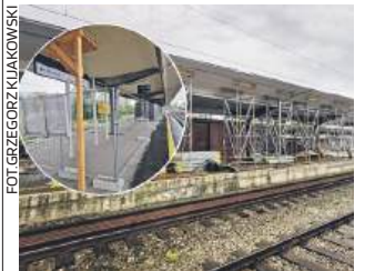
Na stacji trwa obecnie remont wiaty na peronie nr 1.
