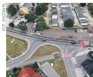
Kierowcy mogą już korzystać z przebudowanej drogi
