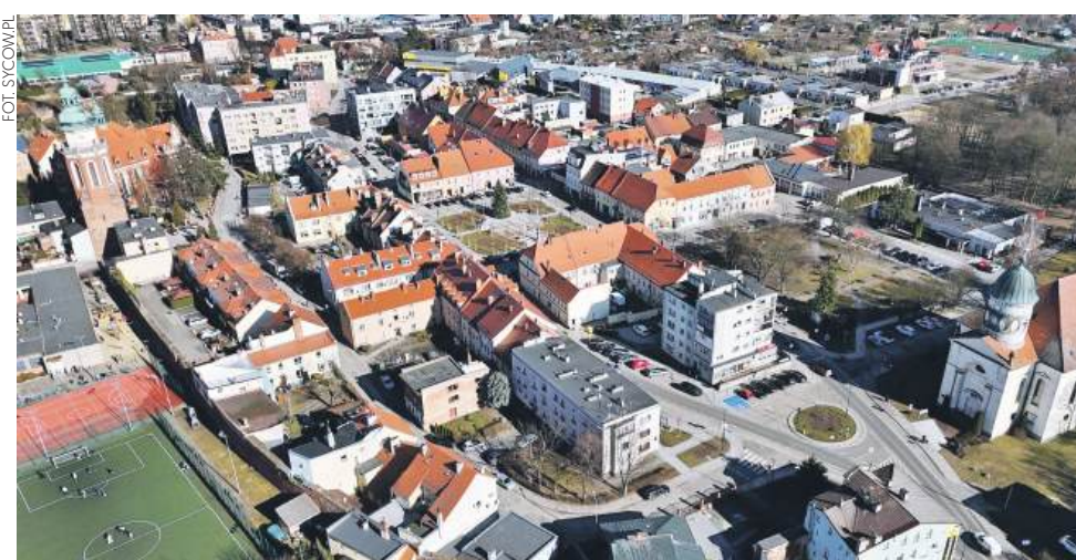
Niebawem gmina wyłoni wykonawcę przebudowy ul. Wałowej w Sycowie
