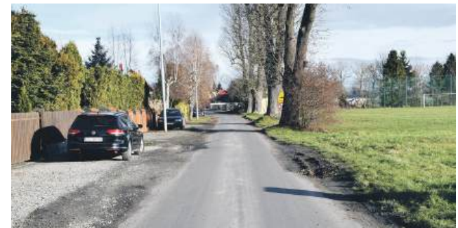
Przebudowa drogi gminnej nr 102167D w m. Świerzna
