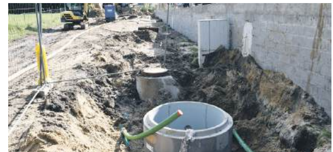
Budowa sieci kanalizacji sanitarnej w m. Jenkowice etap IA, II oraz w m. Sokołowice G. Górka etap I (kontynuacja)
