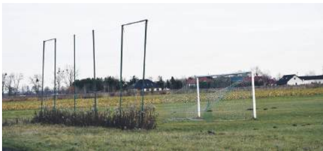
Budowa boisk wielofunkcyjnych w m. Dąbrowa, Boguszyce Osiedle i Ligota Mała
