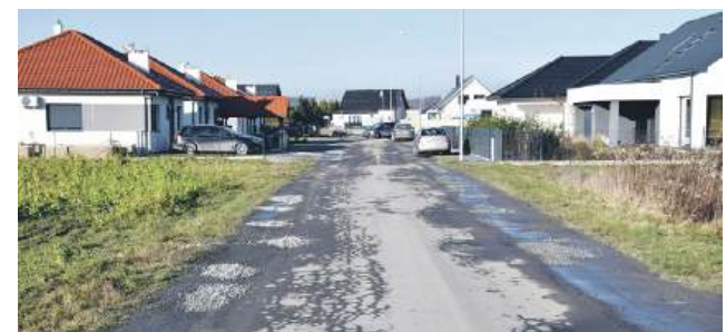
Przebudowa drogi wewnętrznej dz. nr 225 w m. Dąbrowa (osiedle Jenkowice)
