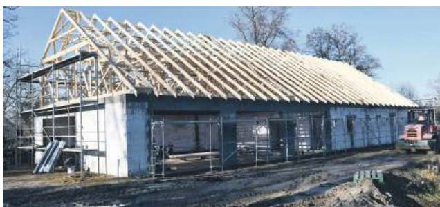
Trwa budowa świetlicy w Spalicach
