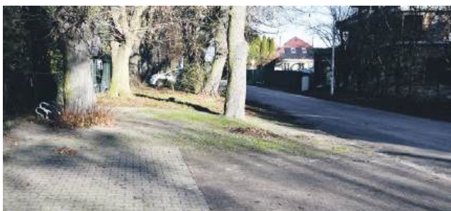
Budowa chodnika wraz z kanalizacją deszczową w pasie drogi wewnętrznej w m. Nieciszów ul. Lipowa
