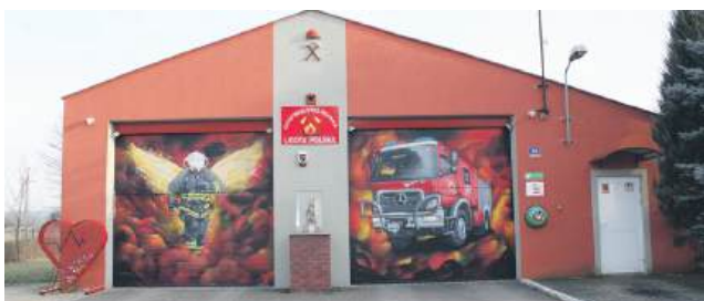
Rozbudowa i nadbudowa budynku remizy oraz termomodernizacja budynku remizy w m. Ligota Polska
