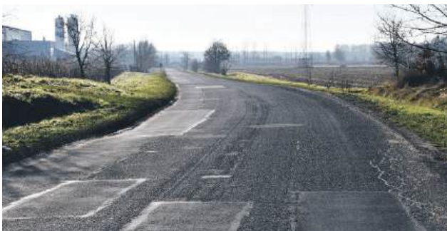
Przebudowa drogi gminnej w m. Smardzów etap II
