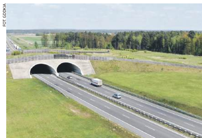
Prace remontowe na S8 już trwają
