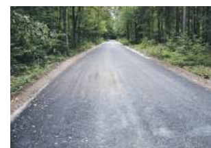
Trwają prace w Osadzie Leśnej
