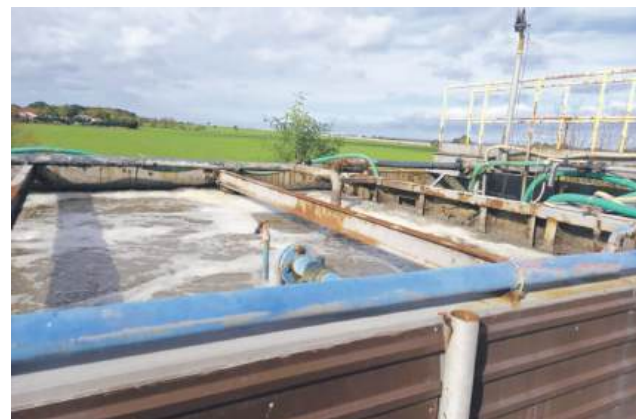
Ten obiekt zostanie wyremontowany i zmodernizowany
