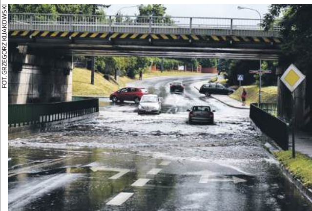
Czy jest szansa, by wiadukt był przejezdny po dużych ulewach?
