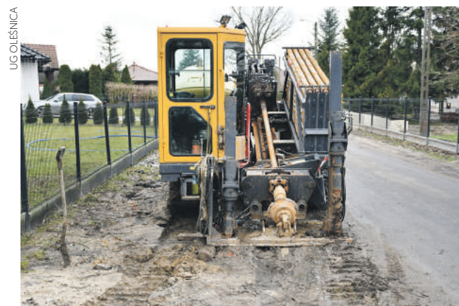
Budujemy kolejne odcinki kanalizacji w gminie Oleśnica
