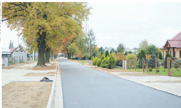
Wyremontowana ulica Lipowa w Dobroszycach
